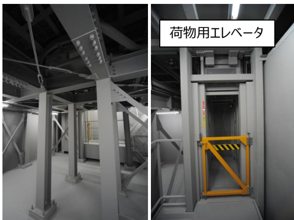
図2: 第1電波暗室の地下ピット
